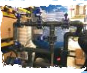
**El sistema AFG** ha sido diseñado para un flujo continuo y suficiente, se proporciona un lavado a contracorriente cada 24-48 h. El volumen libre requerido para esta fase es del 40%. El intervalo será confirmado durante la puesta en servicio. Los diferentes pasos de esta limpieza del filtro se realizarán automáticamente
