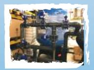
**Système AFG** a été pensé pour un débit en continu et suffisant, un détassage à contre-courant est prévu tous les 24-48h. Le volume libre nécessaire pour cette phase est de 40%. L'intervalle sera confirmé lors de la mise en service. Les différentes étapes de ce nettoyage du filtre se feront automatiquement.
